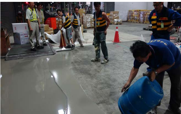
將拌勻的「凱勒米」自平泥鋪設於地坪上
