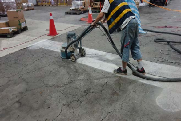
以研磨機將素地上的土屑等凸出物磨除並全面徹底清洗乾淨。
