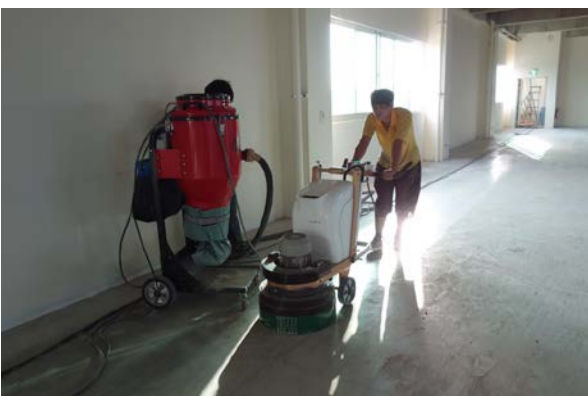
以研磨機進行研磨與熱融處理
