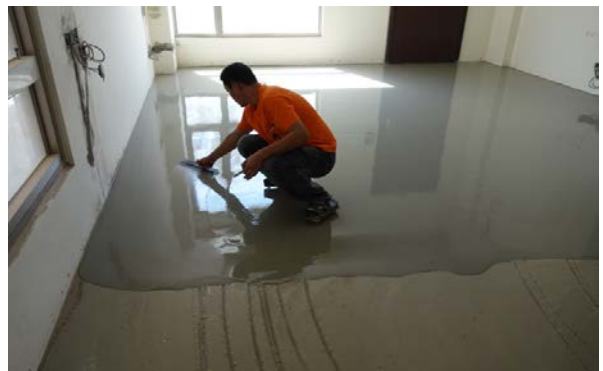
將「凱勒米」自平泥耙平且消泡滾平
