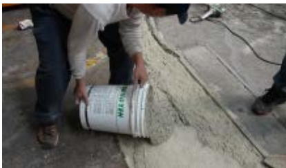
4. 澆築含七厘石的「即固 E-120 水泥砂漿」作為粗底材
