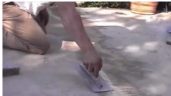
6. 將「即固 E-120」水泥砂漿鏟平
