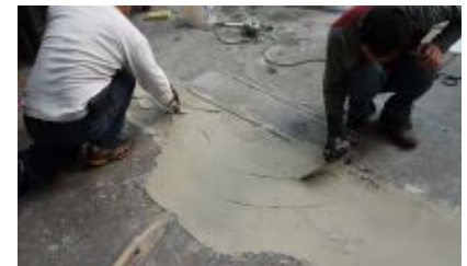
6. 以「即固 E-120 水泥砂漿」(不含七厘石)鏝平作為面材
