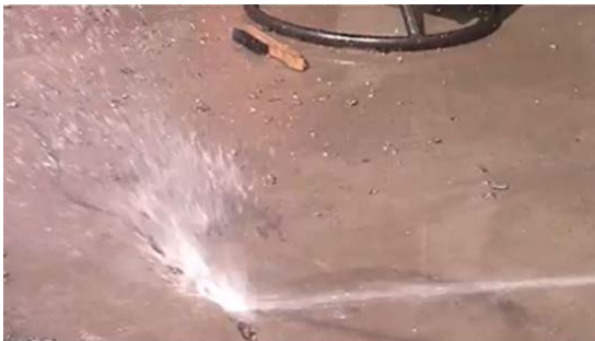
3. 用水沖洗清除裂縫中的碎塊
