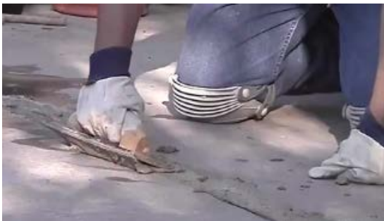
5. 將「即固 E-120」水泥砂漿按壓入裂縫中
