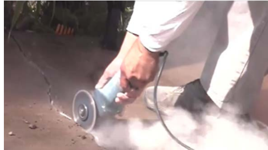
2. 使用電鋸切除鬆弛的混凝土碎塊
