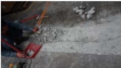
1. 表面敲除至完整的混凝土面
