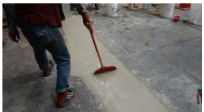
7. 用掃帚掃粗，以增加表面粗糙度。
