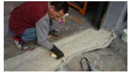
3. 抹上「即固 E-120 水泥砂漿」的薄漿，以加強結著性。
