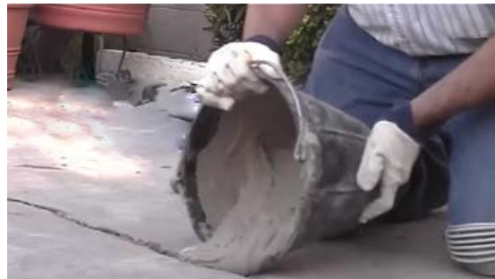
4. 沿著裂縫倒入「即固 E-120」水泥砂漿
