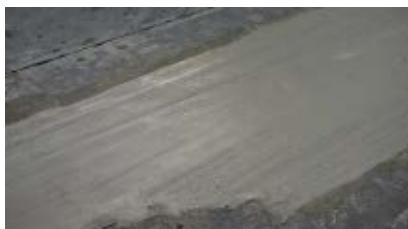
8. 完成面潮濕光澤消失後，立即用水進行養護至表面完全硬化。
