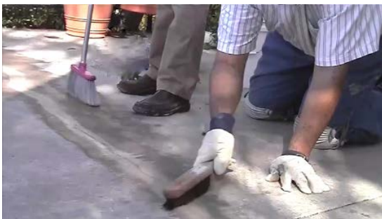
7. 將鏟平的水泥砂漿掃粗
