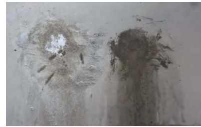
漏水孔止水完成
