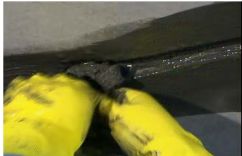
以「克漏牆防水修補砂漿」將鑿除的凹洞補平
