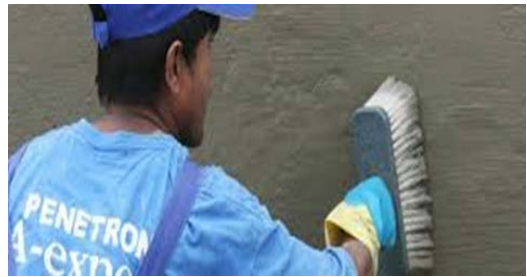
使用硬質刷刷塗施工
