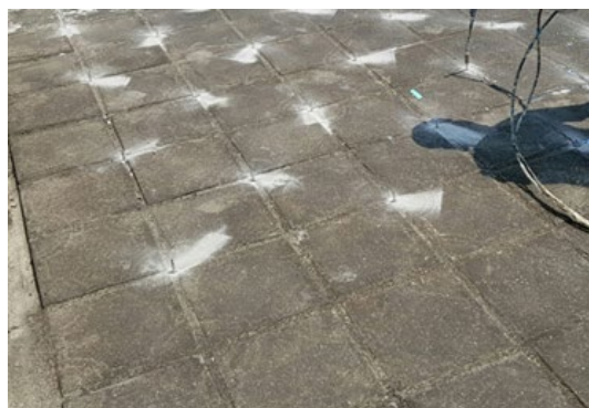
棋盤式鑽孔灌注「喜治漏」強效止漏劑
