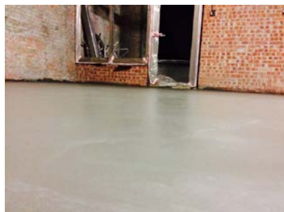
整體粉光後形成抗滲性的混凝土地坪，具抗磨耗性、不易起砂。
