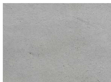
添加「即固 T-280」的混凝土面未呈現乾縮龜裂
