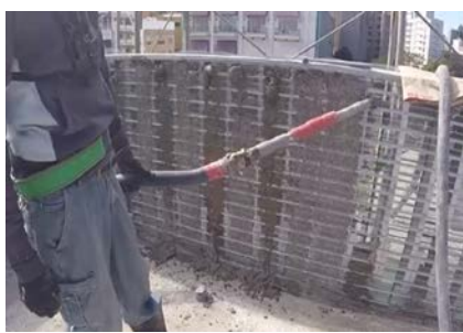
「即固 T-280」水泥砂漿具團聚力，減少泌水，充分填滿免拆網內間隔空間。
