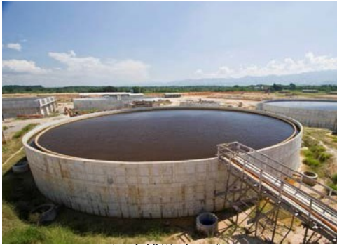
污水槽防水工程
