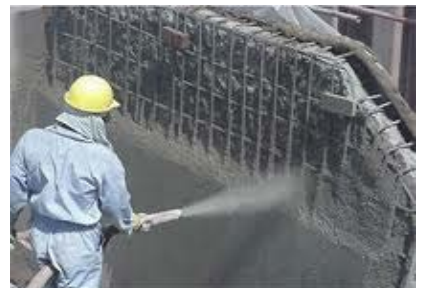
「即固 T-280」噴漿工法，附著力佳，噴漿厚度可堆疊至 10cm 以上。
