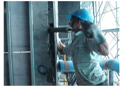
「即固 T-280」水泥淨漿量高，具潤滑性，窗框嵌縫灌注一次完成。
