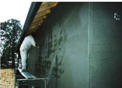
「即固 T-280」外牆打底粉刷，具抗滲性，不易產生白華，不易起粉塵。
