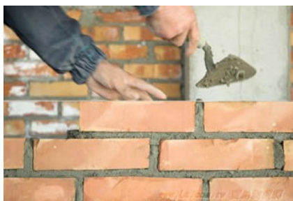
「即固 T-280」所形成的超微細水泥可提高磚與磚的結著強度。
