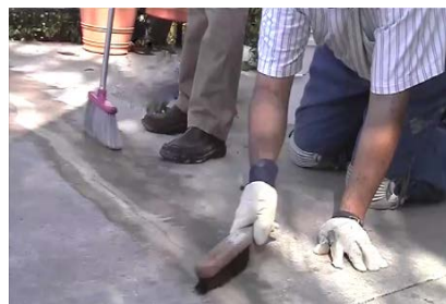
7. 將鏝平的水泥砂漿掃粗
