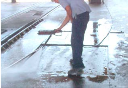
1. 電鋸切割並鑿除破損混凝土後潤濕
