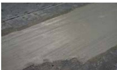
8. 當表層的潮濕光澤消失後，立即用水養護，直至表層完全硬化。
