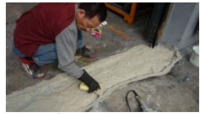
3. 抹上「即固 E-120 水泥砂漿」的薄漿，以加強結著性。
