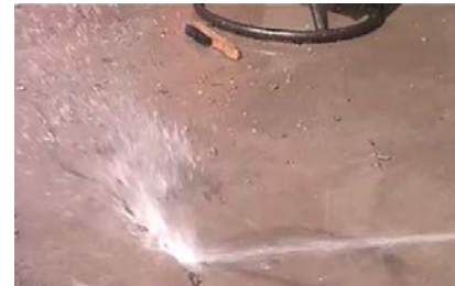
3. 用水沖洗清除裂縫中的碎塊
