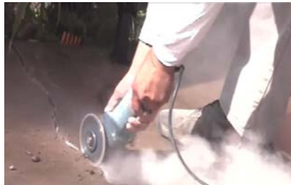
2. 使用電鋸切除鬆弛的混凝土碎塊
