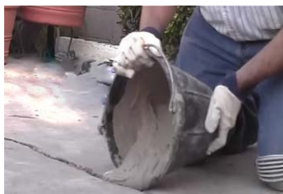
4. 沿著裂縫倒入「即固 E-120 水泥砂漿」
