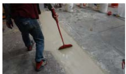
7. 用掃帚掃粗，以增加表面粗糙度作為止滑。
