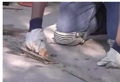
5. 將「即固 E-120 水泥砂漿」按壓入裂縫中
