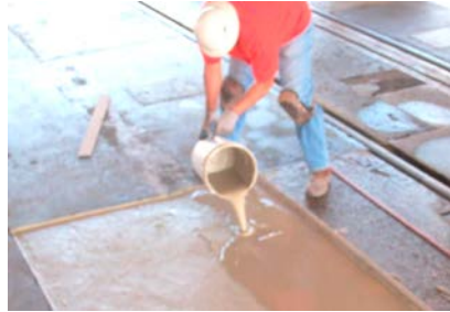
2. 倒入「即固 E-120 水泥砂漿」
