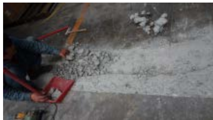
1. 敲除破損處至完整混凝土面
