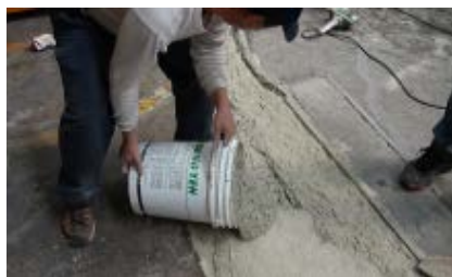
4. 澆築含七厘石的「即固 E-120 水泥砂漿」作為粗底層
