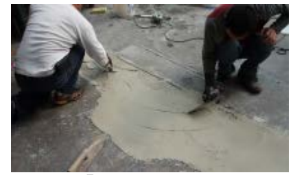
6. 鏝抹「即固 E-120 水泥砂漿」作為面層
