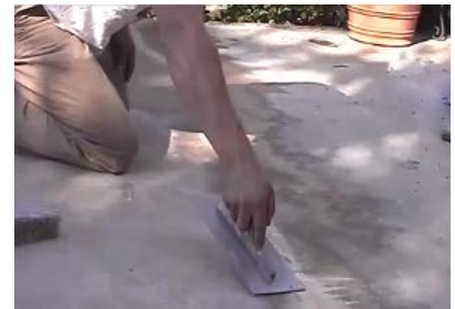
6. 將「即固 E-120 水泥砂漿」鏝平
