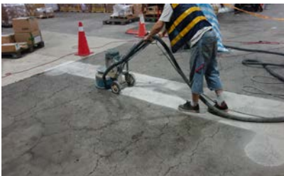
舊地坪表面前處理
