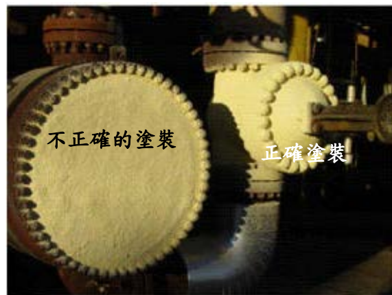
整組閥門全面塗裝 20mm 後的溫度降至 57 ^{\circ} C
