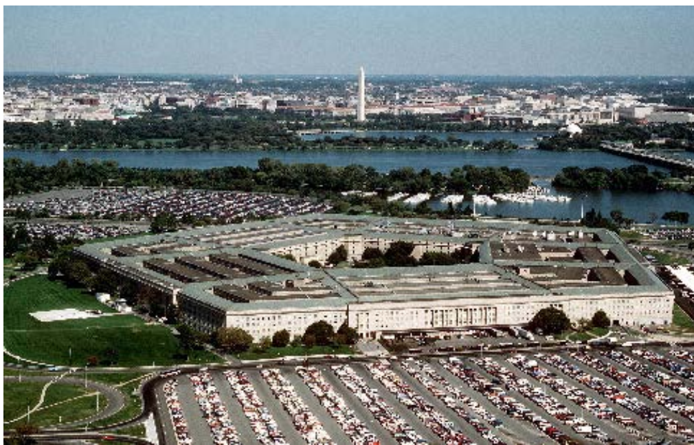
美國五角大廈混凝土結構翻修工程
