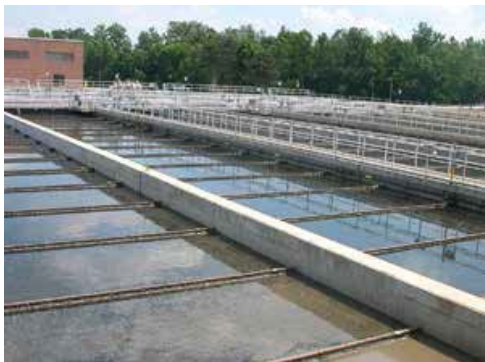
美國維基尼亞州污水處理廠的混凝土添加「克漏牆軀體結晶防水添加劑」後可保護其不受危險化學物質的侵蝕。
