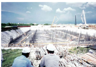
台灣奇美南科液晶廠新建工程
