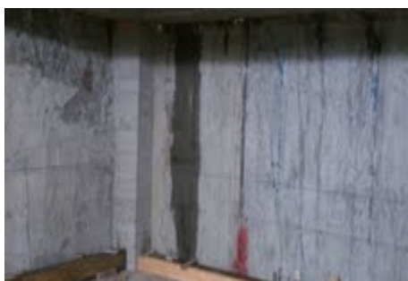
地下B3連續壁滲水處以硬質長柄刷用水清洗乾淨後，塗刷「克漏牆表面噴塗劑」。
