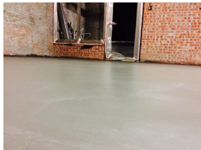
整體粉光後形成抗滲性的混凝土地坪，具抗磨耗性、不易起砂。
