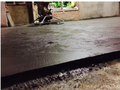
混凝土地坪調漿時產生飽足的水泥漿體
