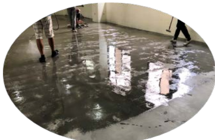
地坪裂縫修補施工
