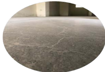
地坪寬裂縫完成修補
