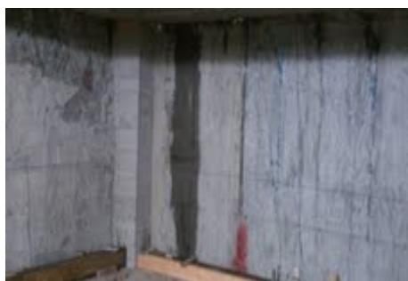
地下連續壁潮濕處以水清洗乾淨，再以硬質毛刷塗刷「克漏牆滲透結晶防水劑」。
